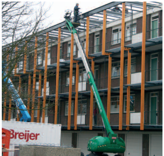
Renovatie galerijflats Platen.
