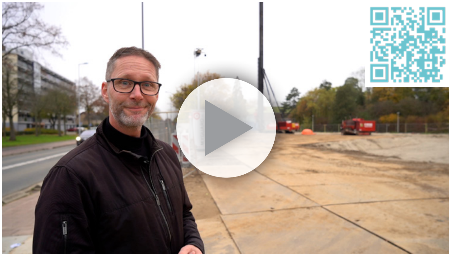
In november ging de bouw van Nieuw Welgelegen echt van start. Jaco Witvliet, onze projectleider Vastgoed, was op de bouwplaats en vertelt in de video wat er allemaal gebeurt.
